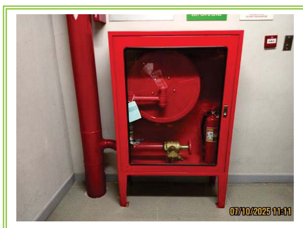
รูปที่ 3-43 ตู้เก็บสายฉีดน้ำดับเพลิงพร้อมอุปกรณ์ (Fire Hose Cabinet : FHC)
