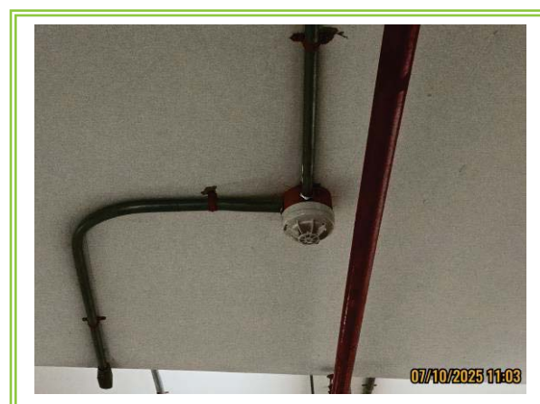
รูปที่ 3-48 เครื่องตรวจจับความร้อน (Heat Detector)
