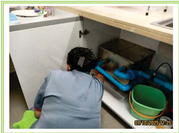
รูปที่ 3-13 เจ้าหน้าที่ที่ตกไขมันออกจากบ่อตกไขมัน
