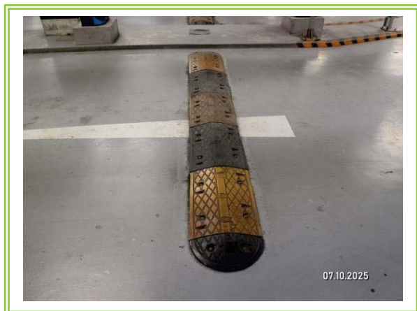
รูปที่ 3-4 สันถนน และเนินชะลอความเร็วของรถ
